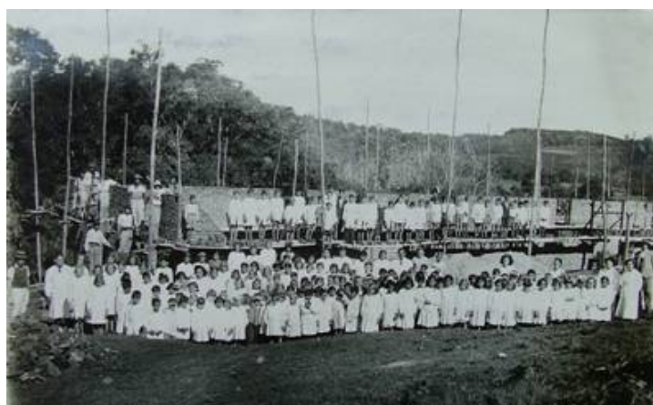
Foto 14: Visita de los alumnos a la obra en construcción para la Escuela N° 77, localidad Olegario Andrade, Misiones. Archivo Láinez
