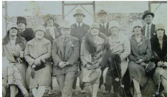
Foto 1: Fotografía obtenida antes de iniciarse la construcción del edificio actual con el personal directivo, docente, especial y visitante. Escuela N° 6 “12 de Octubre”, San Antonio Oeste. Río Negro, 1928. Archivo Láinez.
