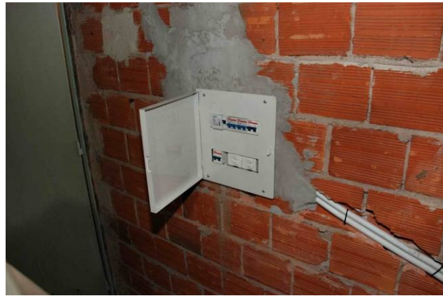
Diciembre 2009 Instalaciones eléctricas
