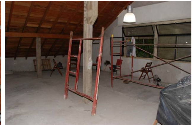
Febrero 2010 Luminarias y revoque de paredes
