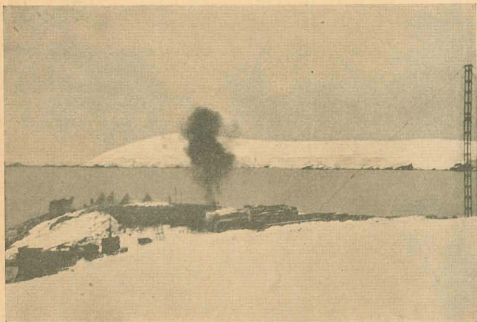
Vista de una voladura efectuada en la puerta Observatorio de la isla Gamma, para levantar los cimientos del Observatorio de Puerto Melchior
