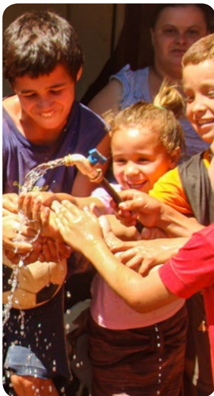
Instalación de una nueva red de distribución de agua potable en el Paraje Independiente, Misiones. Foto: Jonatan Villalba.
