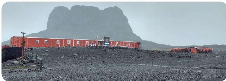
La Base Carlini es la principal estación científica permanente argentina. Las investigaciones más relevantes abarcan la biología costera y terrestre, oceanografía, geología y glaciología. Estas actividades se realizan de manera ininterrumpida desde hace más de dos décadas, lo que ha posibilitado una recopilación de serie de datos científicos dentro de las de más larga data y completa de la región Antártica. Foto: Rodolfo Werner.
