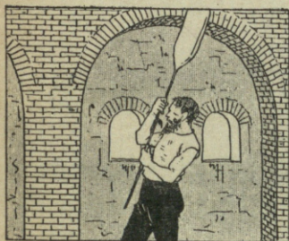
92. Balanceando y haciendo girar la barra, se convierte la pera en un cilindro*, terminado en dos casquetes esféricos*.
