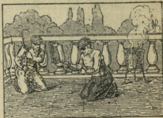
Plomo. — 23. Las láminas de plomo batido sirven para cubrir los pisos de los balcones y de las azoteas expuestos á la lluvia.
