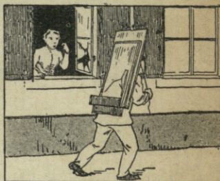
95. Los vidrieros y hojalateros colocan los vidrios en los balcones, ventanas, etcétera, sujetándolos por medio de una pasta llamada masilla .
