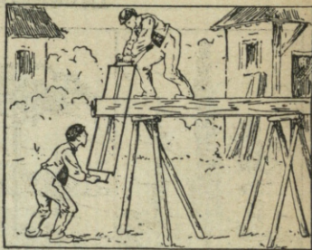
37. Aserrador serrando un madero para hacer tablones.
