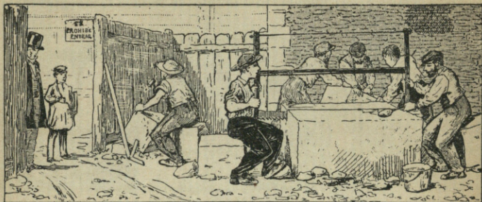
26. Canteros cortando y serrando piedra de construcción.
