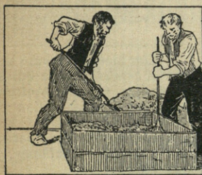
9. Obreros apisonando arena en el segundo bastidor , en el que se deja un hueco por donde se ha de verter el metal.
