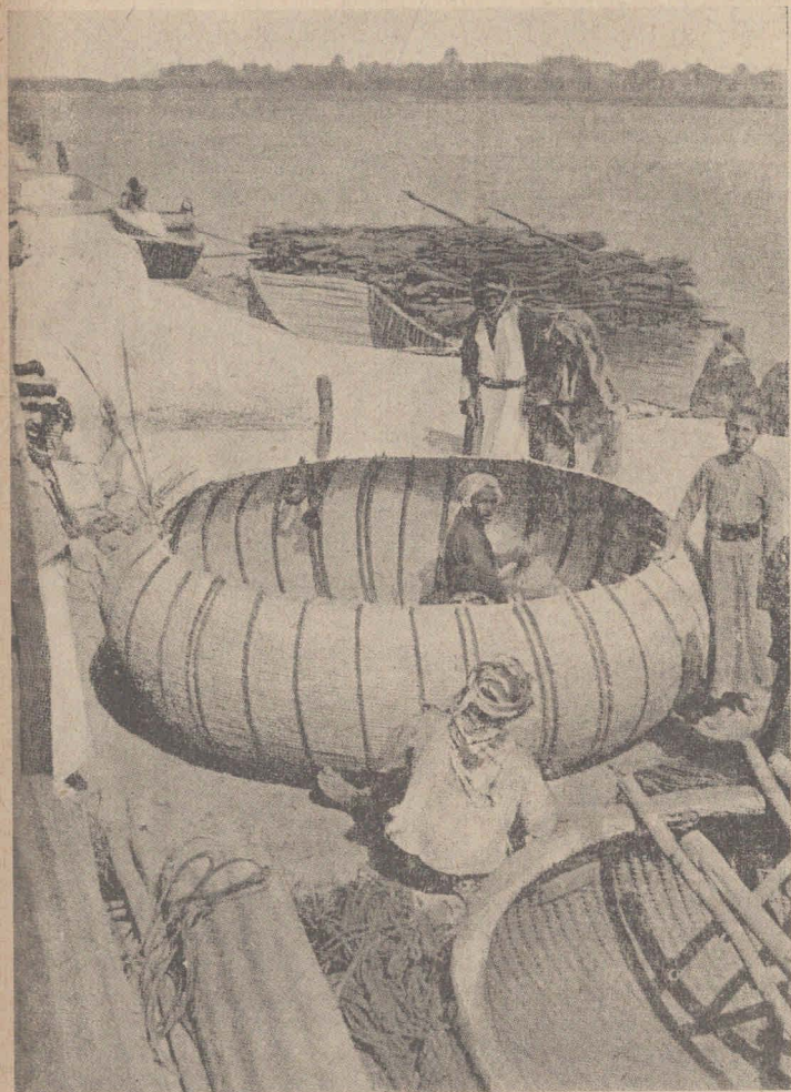
Construcción de embarcaciones en la Mesopotamia.
