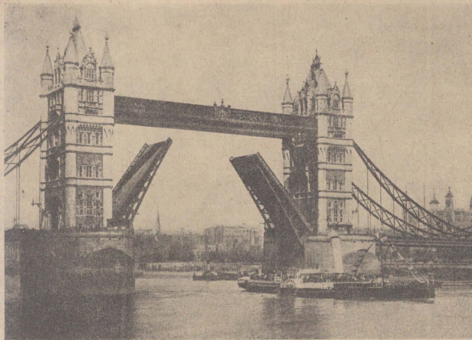
Puente de la Torre de Londres.
