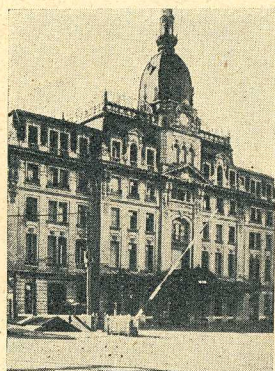
Estación F. C. Central Córdoba
