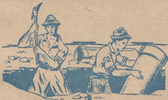
b) En el de las veredas: los albañales y caños de salida del agua; las tuberías del gas; las cañerías del agua corriente; los cables conductores de la electricidad.
