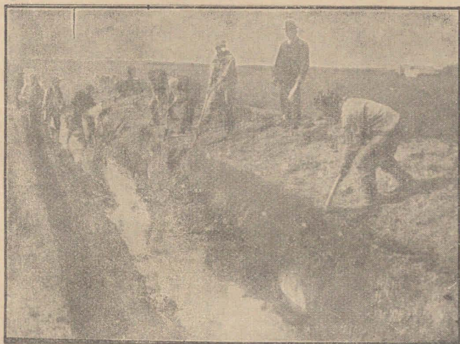
* Desagüe de un campo. Excavación del canal principal.
