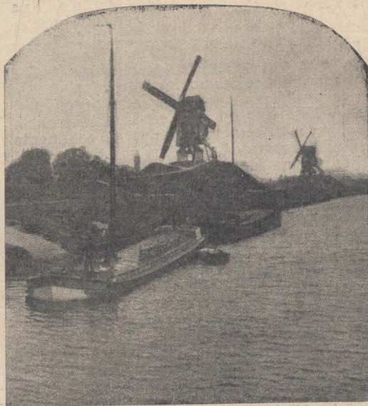
FIG. 54. — Un canal holandés. Los molinos colocados en el dique elevan las aguas del polder que está situado detrás, cuando éste se inunda, y las vierten en el canal.
