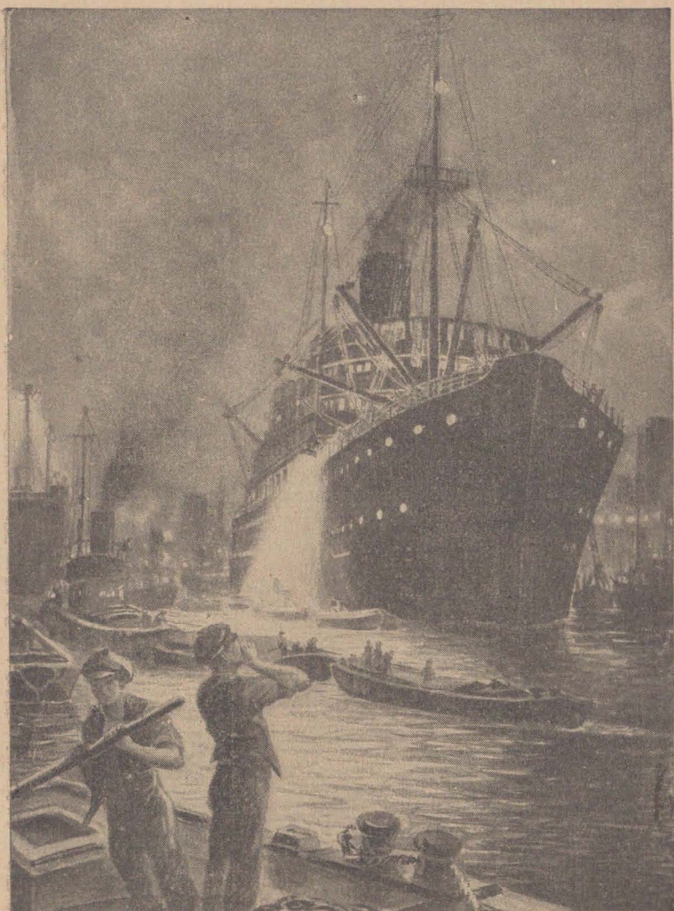
Puerto de Buenos Aires. — Es complicada la tarea de dar ubicación a ese gigante del mar.
