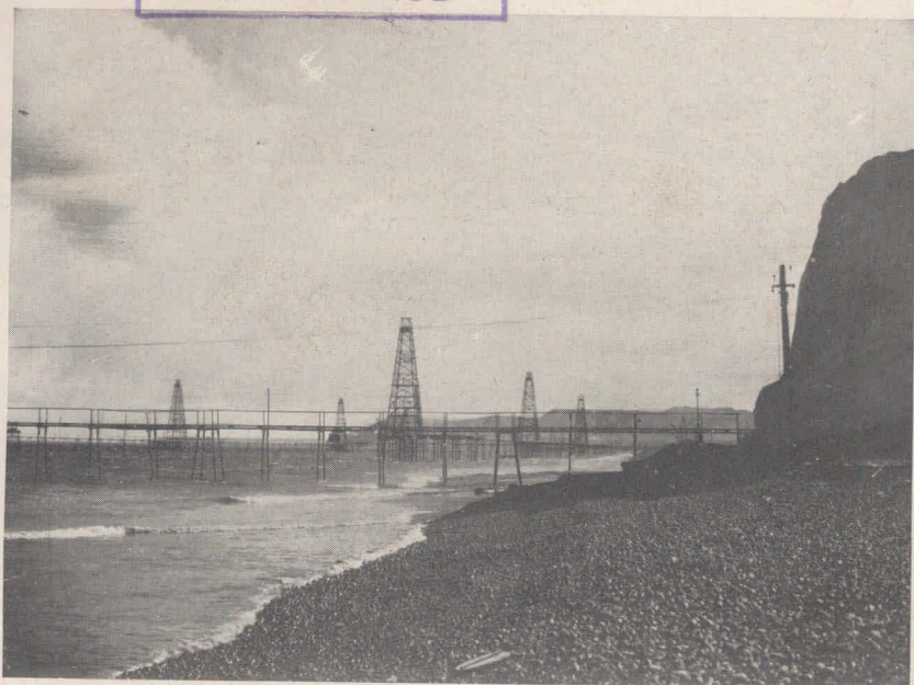
Pozos en producción en el mar. Torres que corresponden a los pozos, cañerías y puentes (pasarelas). Comodoro Rivadavia.
