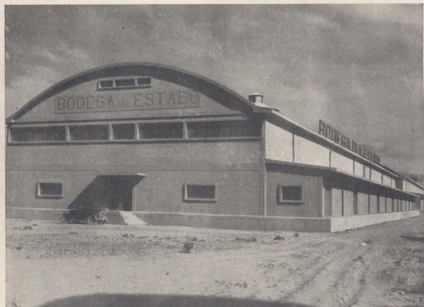
Bodega del Estado en San Juan, con capacidad de 500.000 Hectolitros.
