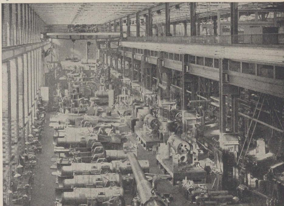
Departamento donde se montan los cañones. Luego de concluido el cañón, y después de ser probado, es conducido a este taller y montado sobre una cureña dotada de los necesarios mecanismos para hacerlo girar horizontal y verticalmente, quedando en disposición de ser instalado en un fuerte o en un buque de combate.
