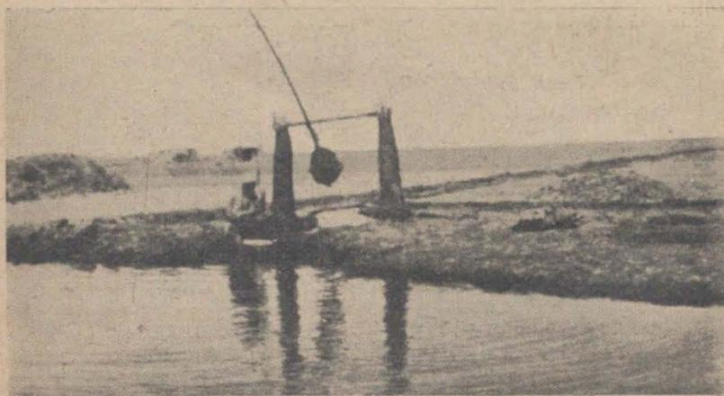
Fig. 32. — Primitivo procedimiento de irrigación en Egipto: el *chaduf*.
