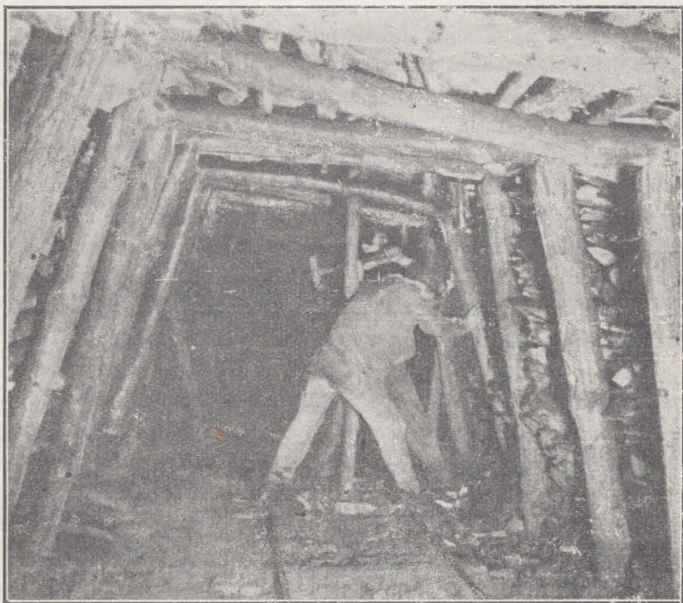
FIG. 86 - Una mina. - Construcción de galerías.
