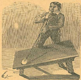
Fig. 89. — Sopragem dos cylindros para vidros de vidraças
