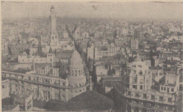
Otro aspecto de la Capital Federal. Se ve la torre del edificio ocupado por el Concejo Deliberante.
