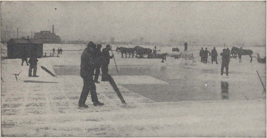
Cortando el hielo, por medio de una sierra, después de cuadrículado.
