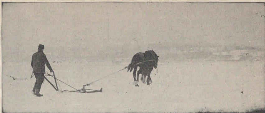
Cuadrículando el hielo, antes de comenzar los trabajos, para que pueda ser cortado de una manera uniforme.
