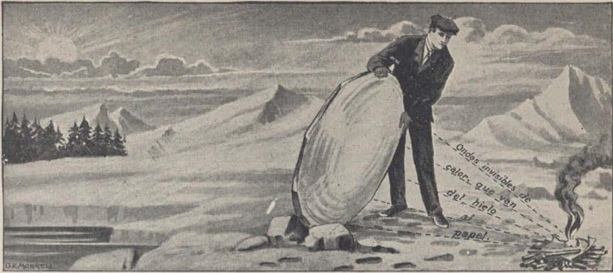
Si se hacen pasar los rayos del sol a través de un pedazo de hielo tallado en forma de lente, las ondas caloríficas conservarán su calor, a pesar de que el hielo esté frío, y encenderán un montón de madera y de papel, según nos muestra el grabado.
