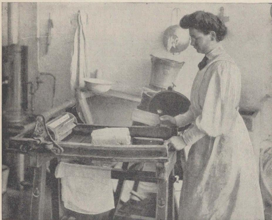
El cilindro acanalado corre adelante y atrás, y aplasta los granitos convirtiéndolo en una masa sólida al mismo tiempo que escurre el agua que pueda aun contener. Luego aquella mantequilla se dispone en pedazos de un peso de kilo o de medio kilo cada uno, y ya puede servirse en la mesa.
