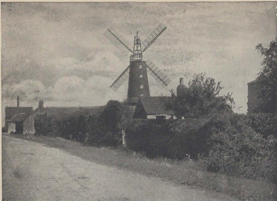
Ahora ya tenemos el trigo en disposición de ser llevado al molino y convertido en harina. Hay molinos de diferentes clases, de viento, agua o vapor. El del grabado es de viento, el cual al chocar con las aspas del molino las hace dar vueltas y este movimiento es transmitido a los cilindros que trabajan en el interior del molino.
