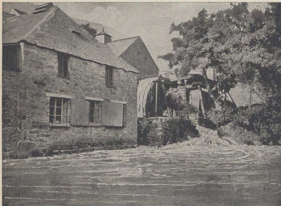
Cuando un molinero de un molino de agua desea moler trigo, cierra las compuertas deteniendo la corriente y deja llenar de agua una gran balsa. Cuando se le abre el paso, el agua previamente depositada cae en una especie de cajones de que está provista la rueda hidráulica y la obliga a dar vueltas; este movimiento de la rueda se comunica a las muelas y las hace rodar también y pulverizan el trigo.
