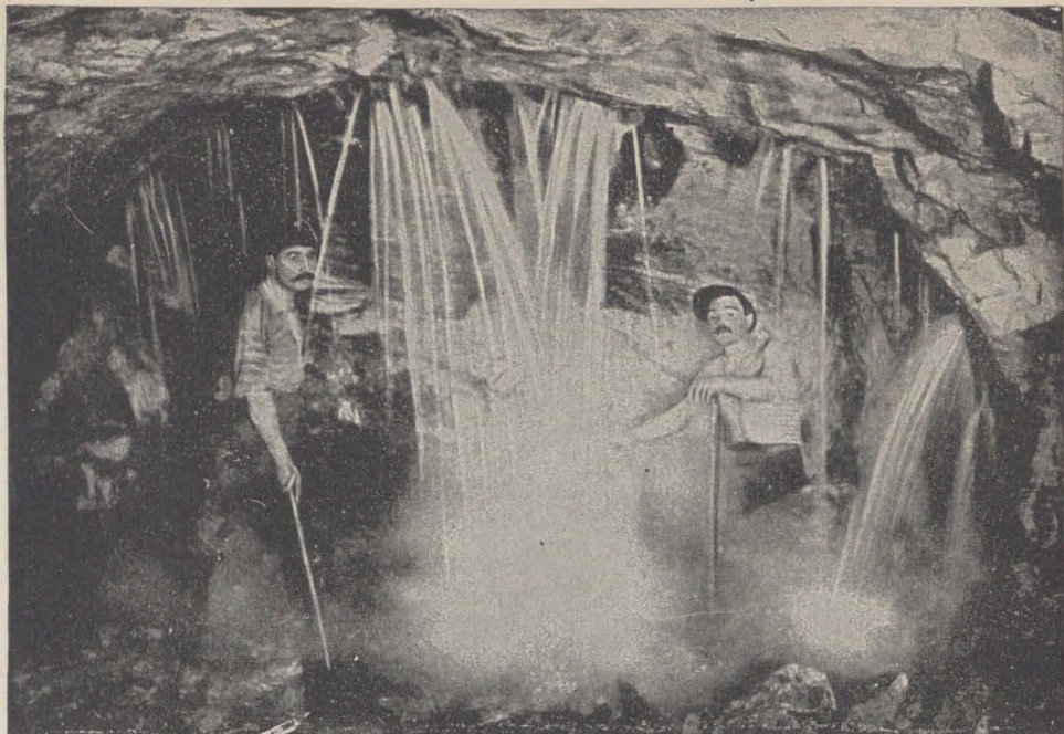
Después de hacer volar la roca, los obreros están expuestos, con frecuencia, a parecer ahogados por el agua que mana de las grietas. Algunas veces, esta agua es sumamente caliente.
