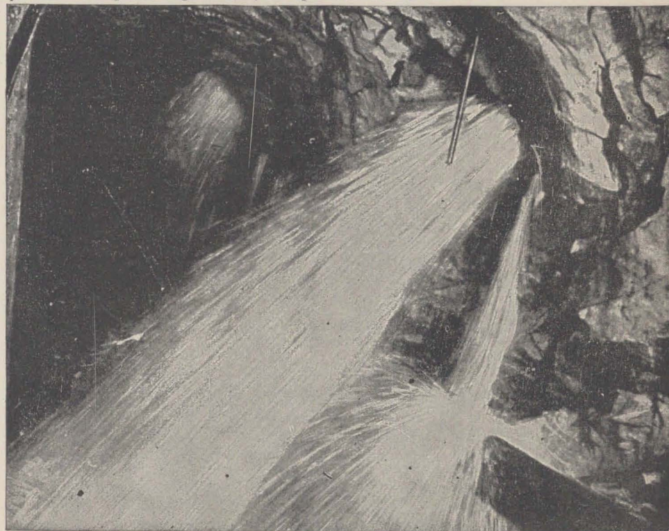
El agua invade la galería como un torrente impetuoso, descargando algunas veces 65,000 litros por minuto. El grabado nos muestra un manantial de agua fría cuya irrupción ocasionó en las obras un retraso de varios meses.
