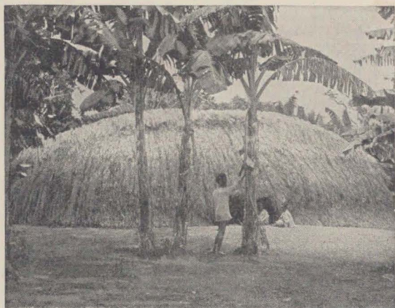
CASA EN SANTA CRUZ, CONSTRUÍDA BAJA CON OBJETO DE EVITAR LOS HURACANES
