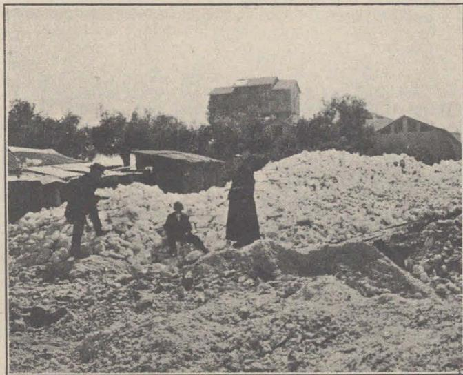
Fig. 242.—Minas de fosforita de Logrosán (Cáceres): montones de mineral y fábricas de superfosfato, o de conversión de la fosforita insoluble en soluble. (Fot. T. Martín Gil, com. por el prof. Rodríguez Polo).
