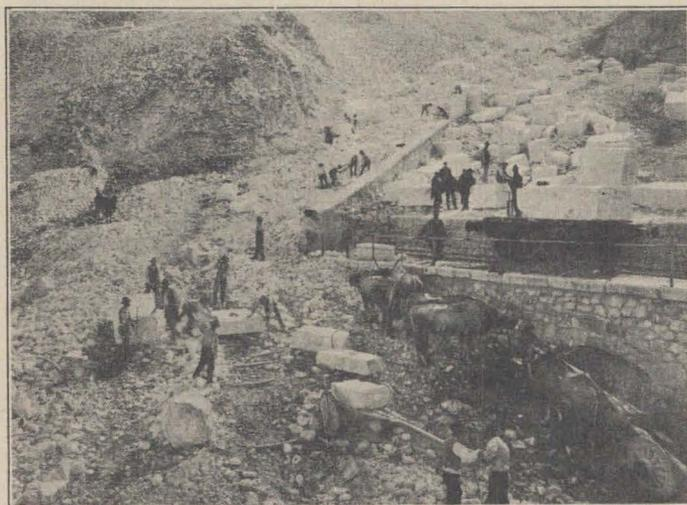
Fig. 225.—Arrastre y carga de sillares en las canteras de Carrara (Italia). (Fotografía comunicada por el Marqués de Maccarani).
