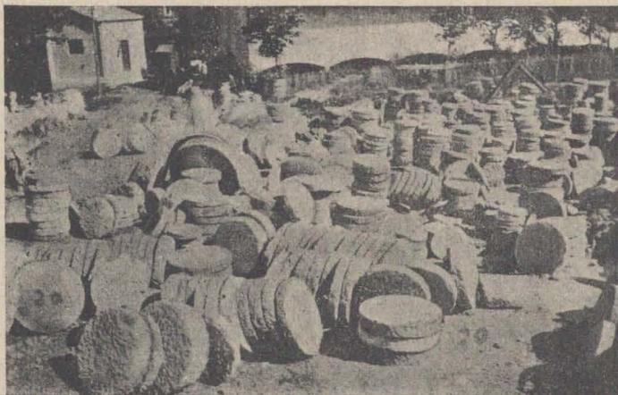
Fig. 368.—Ruedas de afilar obtenidas de la arenisca de la figura 367. (Fotografía O. Cendrero).
