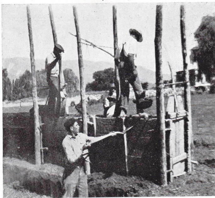
Fig. 5. Tapia de tierra con «molde».
