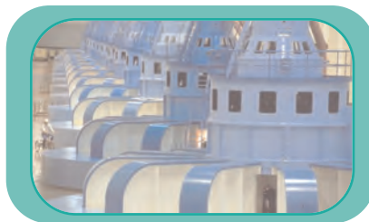
Turbinas hídricas de la central de Salto. Algunas de ellas generan energía eléctrica de 50 Hz, y otras de 60 Hz, para vender su energía al exterior
