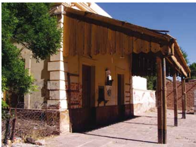
Vieja estación de ferrocarril.
