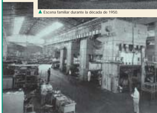
▲ Interior de una planta metalúrgica estatal.
