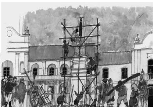
LÁMINA 11 - LA CONSTRUCCIÓN DE LA PIRAMIDE EN 1811
