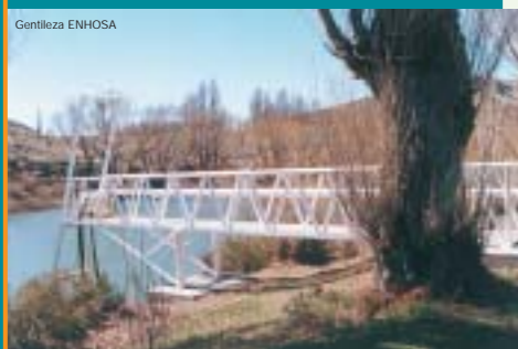
Toma de agua de lago Las coloradas, Provincia del Neuquén
