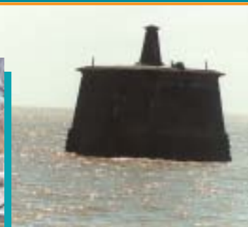
Toma de agua del Río de la Plata, Ciudad de Buenos Aires.
