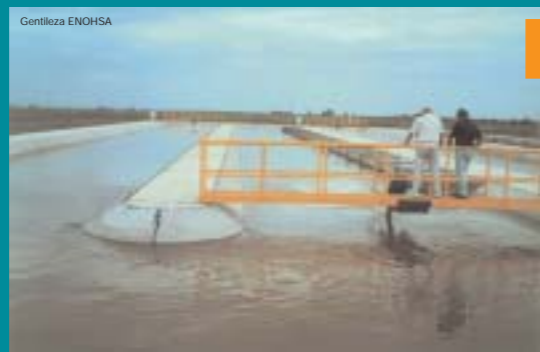
Piletas de tratamiento. San Basilio, Pcia. de Córdoba
