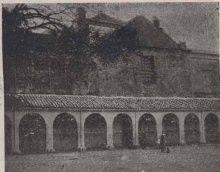
Lado norte del Patio de los Naranjos y costado sur de la Iglesia, tal como han estado desde que se construyó el Colegio, a mediados del siglo XVII, hasta principios de este siglo.
