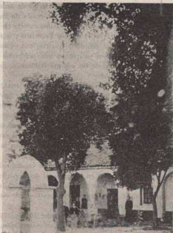
Lado Oeste del Patio de los Naranjos, con el aljibe, que había en el centro del mismo, desde antes de 1767.
